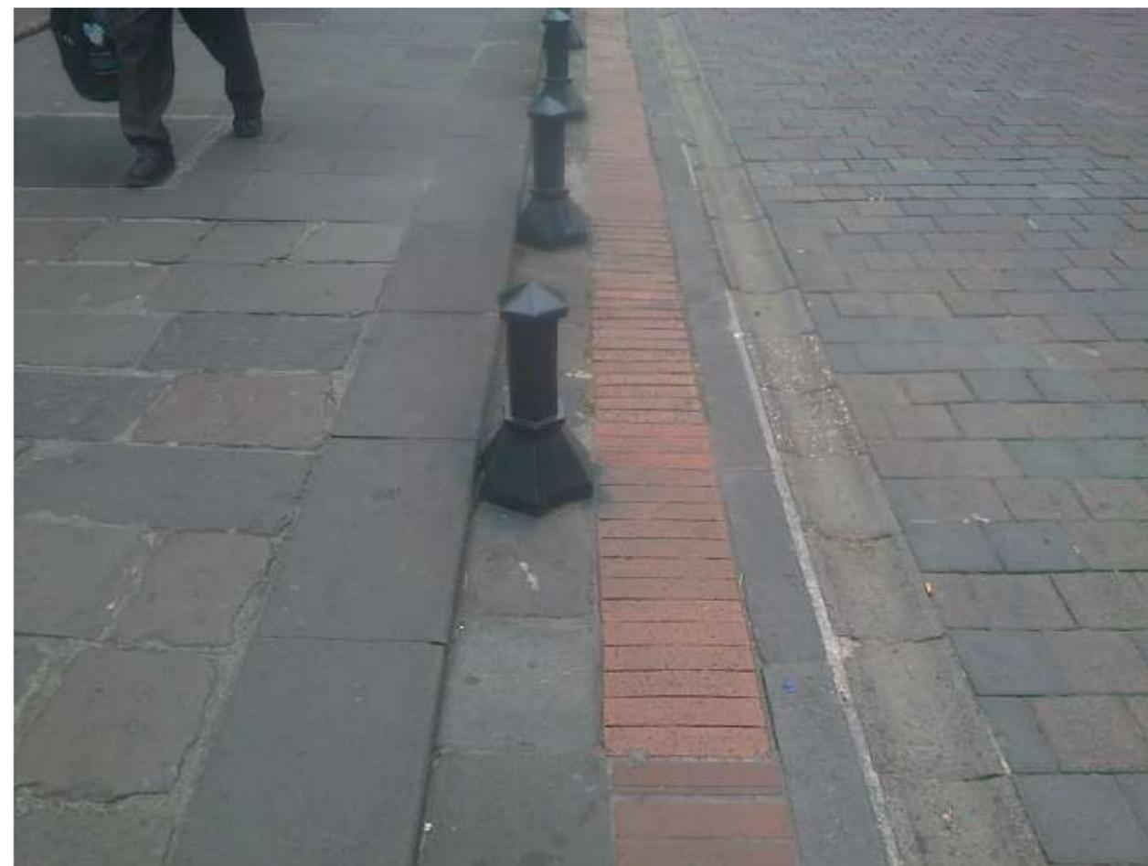
Lo ideal en calles locales es que por los pisos, el agua lluvia se filtre nuevamente hacia el subsuelo, con lo cual se puede recuperar acuíferos naturales. Por lo tanto se recomienda que se utilice empedrados, adoquines con las juntas separadas, los llamados adoquines ecológicos, e inclusive se puede llegar a tener calles verdes si el tráfico al interior es mínimo.
